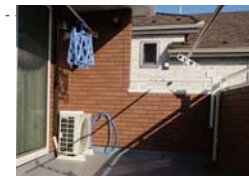
バルコニーには便利な水道を設置
